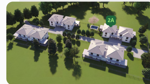
Widok budynków z lotu ptaka
